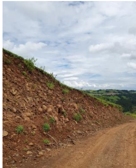
Figura 3 - Talude predominantemente rochoso no acesso interno.
