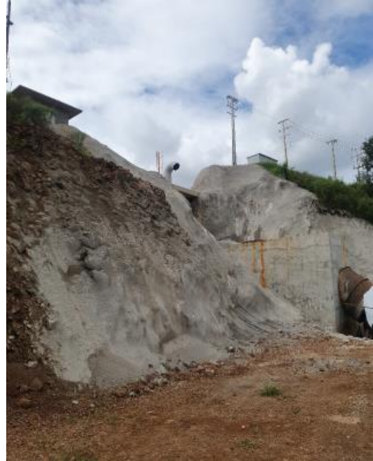
Figura 6 - Talude estabilizado com concreto na região do conduto.
