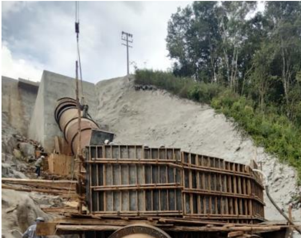
Figura 3 – Talude estabilizado com concreto na região dos condutos.
