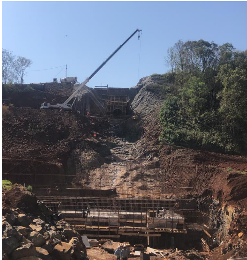
Figura 2 - Estabilização dos cortes em rocha, encostas e taludes na região dos condutos.
