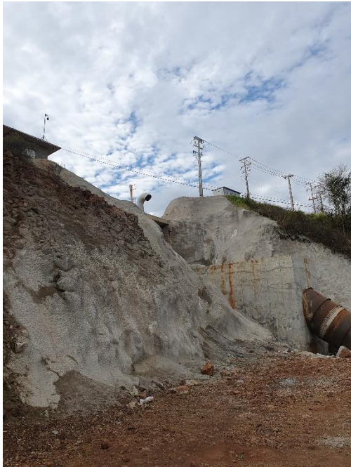
Figura 5 - Talude estabilizado com concreto na tomada d'água.
