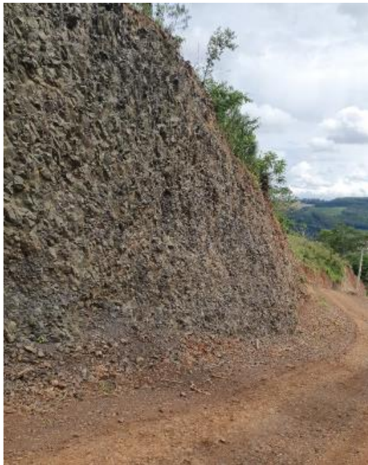
Figura 2 - Talude rochoso no acesso interno.
