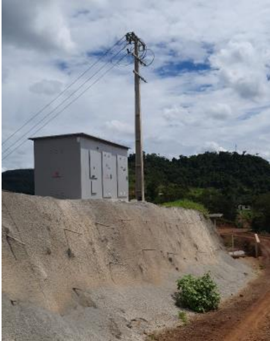
Figura 5 - Talude estabilizado com concreto na tomada d'água.
