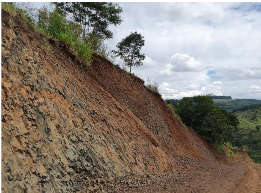
Figura 4 - Talude em rocha no acesso interno.
