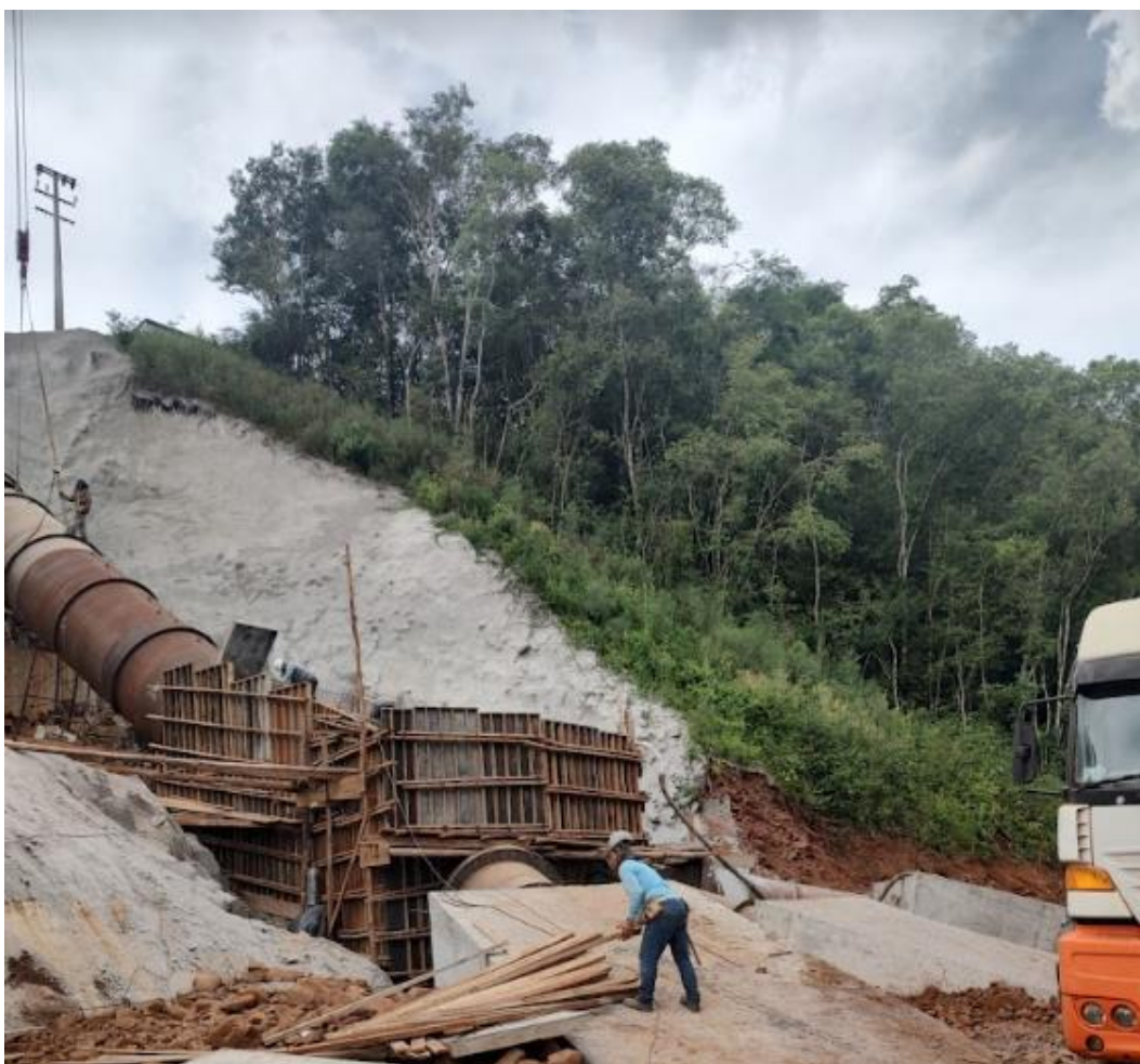
Figura 2 – Taludo estabilizado com concreto na região dos condutos.
