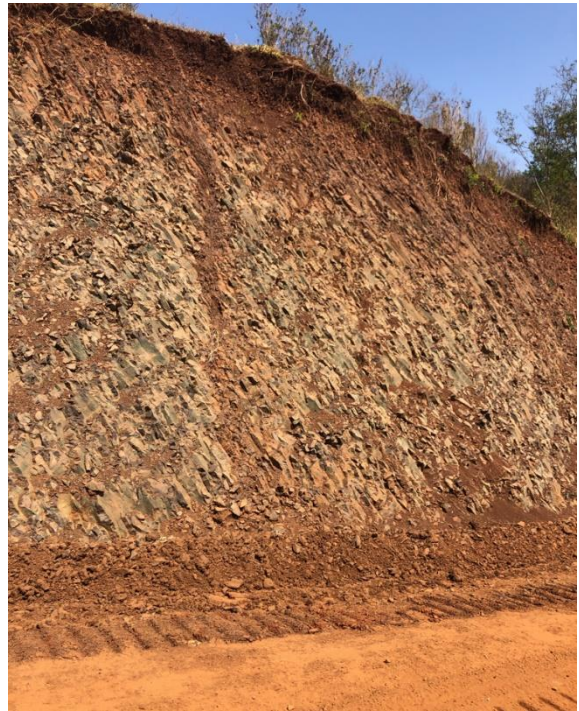
Figura 7 - Talude rochoso de acesso ao empreendimento.
