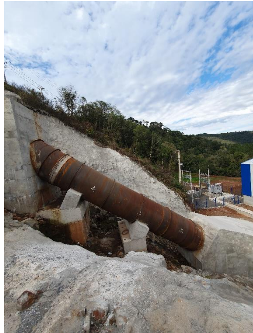
Figura 6 - Talude estabilizado com concreto na região do conduto.
