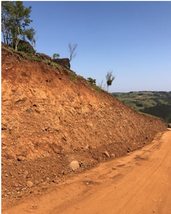
Figura 6 - Talude do acesso ao empreendimento.
