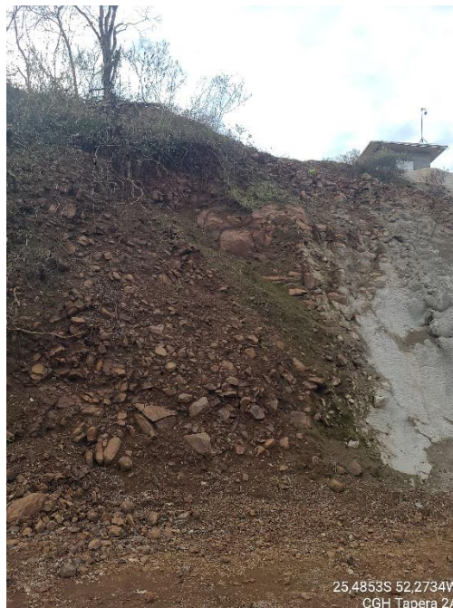
Figura 4 - Talude predominantemente rochoso no acesso interno.
