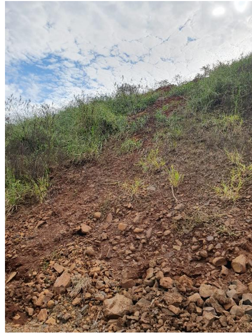
Figura 3 - Talude predominantemente rochoso no acesso interno.
