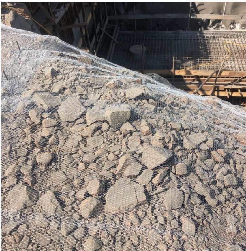
Figura 3 - Telas para contenção de material rochoso.
