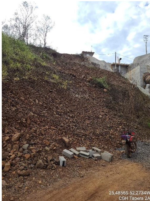
Figura 2 - Talude rochoso no acesso interno.
