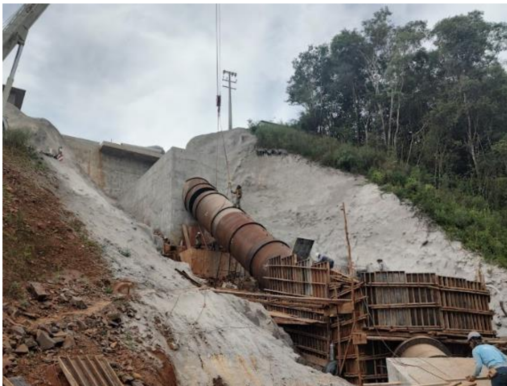
Figura 4 - Talude estabilizado com concreto na região dos condutos.
