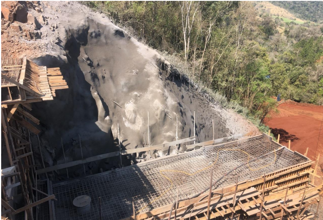
Figura 5 - Concretagem da encosta na região do conduto.
